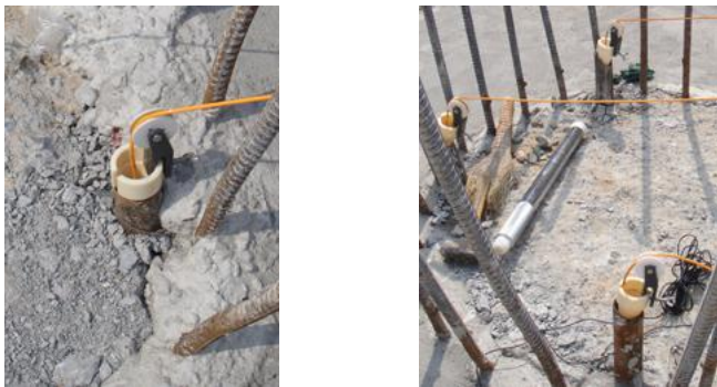
图 F1.2 管口滑轮安装
