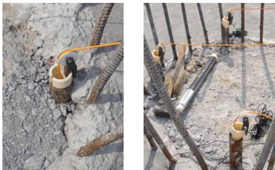
图 9.2 管口滑轮安装
